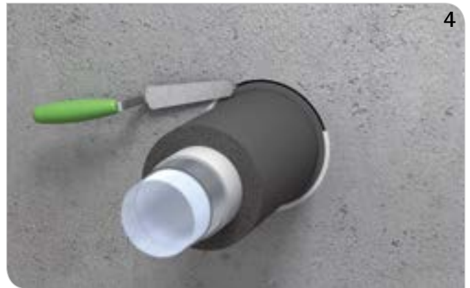
Rest- bzw. Ringspalt rauchgasdicht (mit z. B. Pacifyre® FPM Brandschutzmörtel) verschließen.
