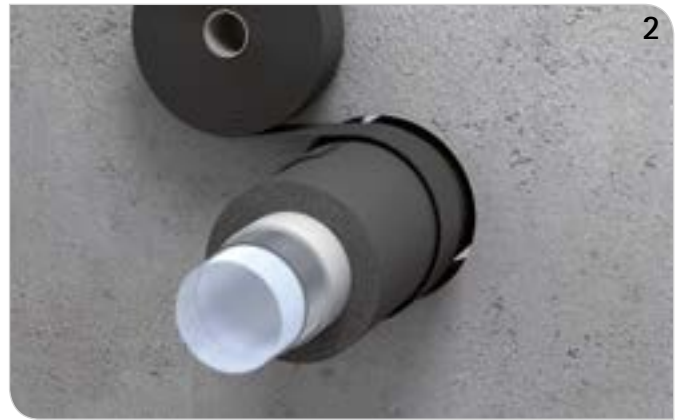
Bandage um Rohrleitung (bzw. Dämmung) legen (Lagenanzahl beachten!) und Überlappung (ca. 20 mm) verkleben.
