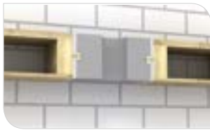
Holzbalkendecke ohne Unterdecke
