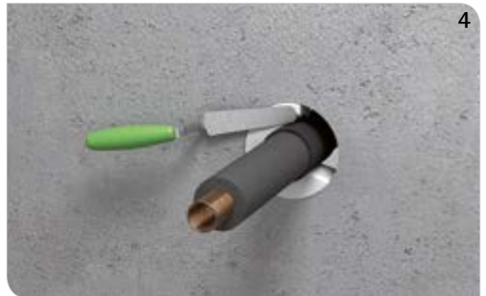
Ringspalt rauchgasdicht (mit z. B. Pacifyre® FPM Brandschutzmörtel) verschließen.
