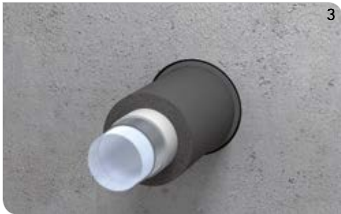
Bandage in Bauteilöffnung schieben (bündig mit Bauteiloberfläche).
