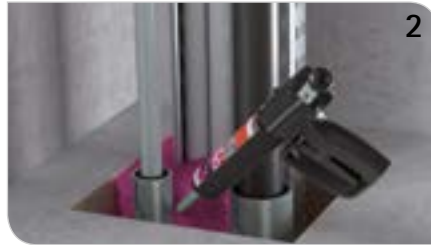
Tangit FP 550 Brandschutz-Schaum einbringen.
