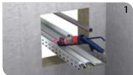
1 Tangit FP 450 Brandschutz-Paste in Bauteilstärke um und zwischen die Kabel flächig auftragen.
