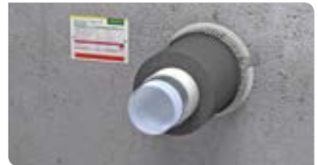
Mehrschichtverbundrohre mit und ohne Synthesekautschukdämmung
