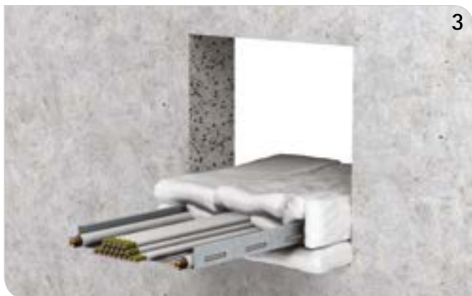
Die Lagen der Pacifyre® IWC Brandschutzkissen so dicht wie möglich um die Kabel verlegen.
