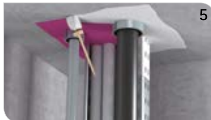
Tangit FP 800 Brandschutz-Anstrich unterhalb des Deckenschotts auf den Schaum und 3 cm des angrenzenden Bereichs, bzw. und 15 cm auf die Kabel(-trasse) auftragen.
