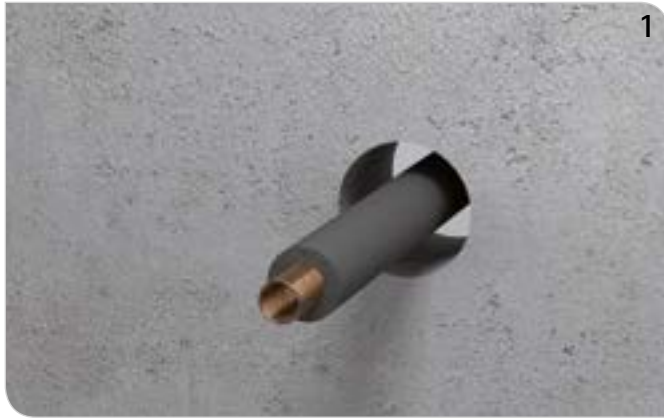
Rohrleitung mit Dämmung installieren.
