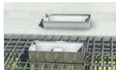
Abschottung von Rohr- und Kabeldurchführungen durch Decken..
