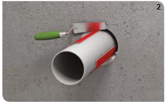
Restspalt rauchgasdicht (mit z. B. Pacifyre® FPM Brandschutzmörtel) verschließen.
