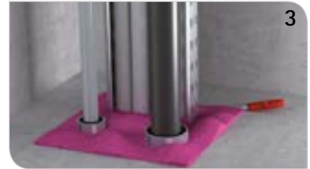
Falls gewünscht, überschüssigen Schaum abschneiden.
