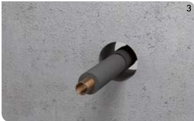
Rohrummantelung in die Bauteilöffnung schieben (Überstände beachten).
