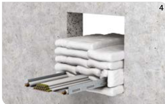
Restöffnungen stoßversetzt mit Pacifyre® IWC Brandschutzkissen verschließen.
