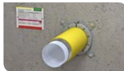
Abschottung von brennbaren Gasleitungen (nach DVGW G600) bis 63mm
