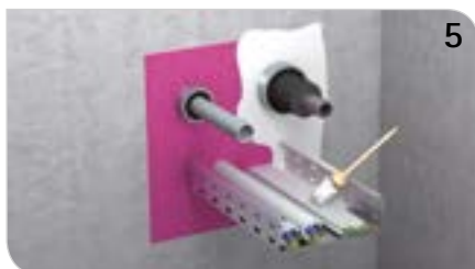
5 Tangit FP 800 Brandschutz-Anstrich auf den Schaum und 15 cm auf die Kabel(-trasse) auftragen.
