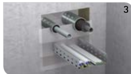
3 Verlorene Schalung mit Klebeband erstellen.
