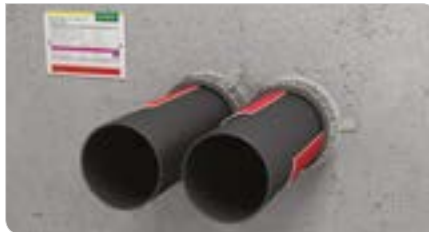
Nullabstand gedämmte Rohre
