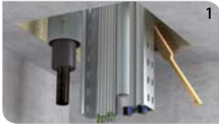
Deckenschott säubern und verlorene Schalung mit Klebeband erstellen.
