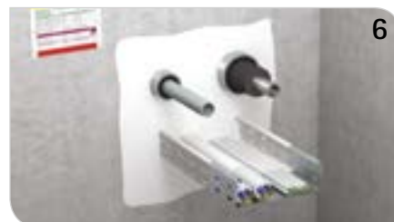
6 Kennzeichnungsschild ausfüllen und neben der Abschottung anbringen.
